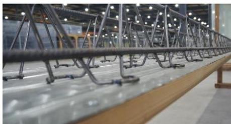
配筋付き製材型枠 (MI デッキ) を用いた天井の木質化 (ホテル・客室) 製材：スギ/カラマツ t25-30
