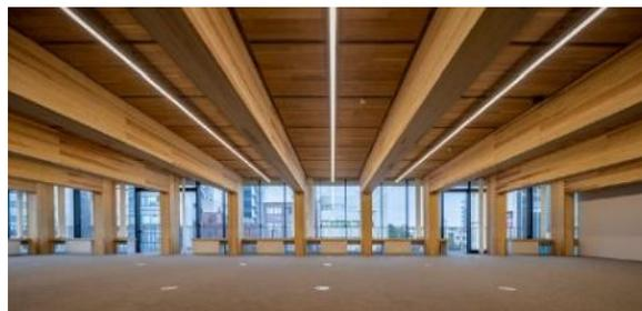
図 5-2 天井材の木質化の例 (木質材料)
