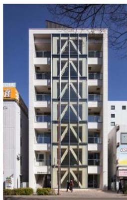
図 5-9 プレースによる木質化の例（木質耐火構造部材）
