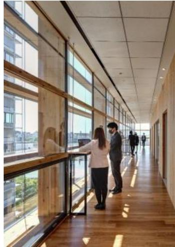
CLT 仕上げ（右の内壁、研修所）
