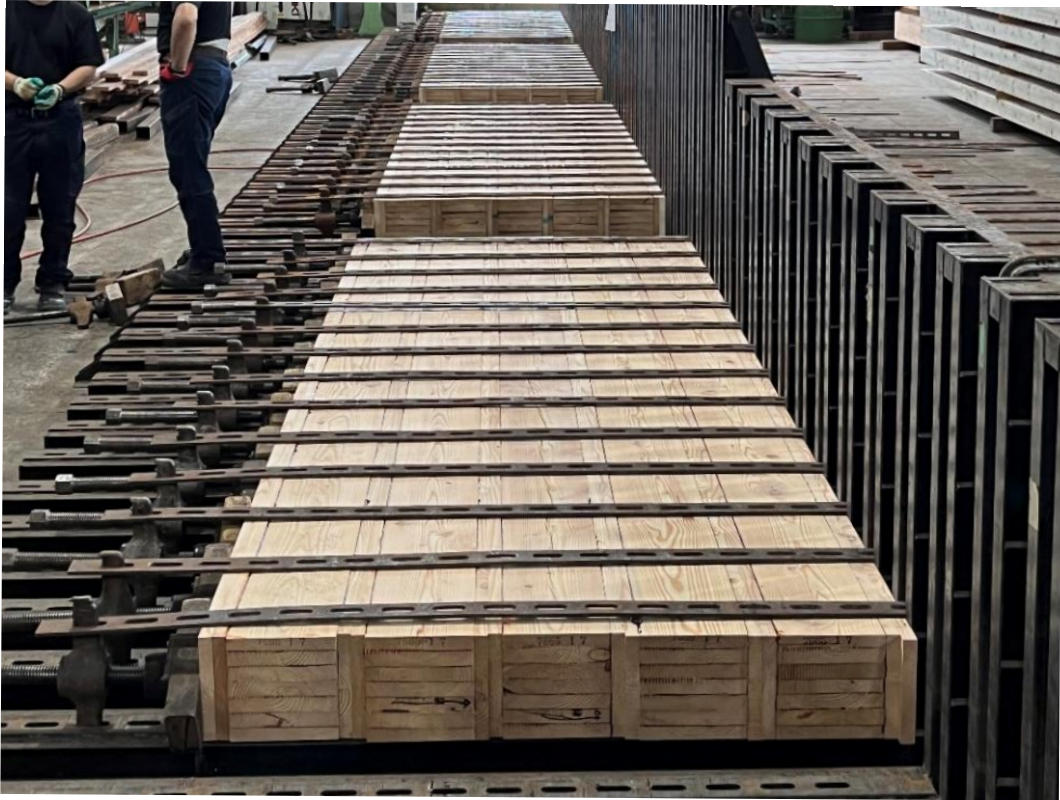
写真 2.1-16 二次接着固定完了
