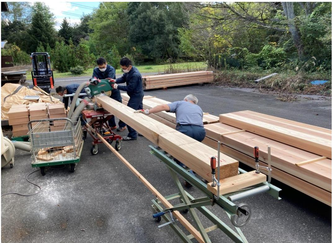
写真 1-11 切片の採取と曲げ試験体の作製
