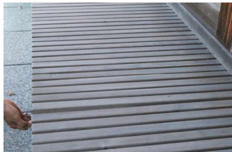
濡れ縁の例 濡れ縁の部材ごとに持ち 上げが可能な納まり
