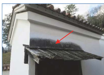
下屋と取り合う外壁面 が汚れている例
