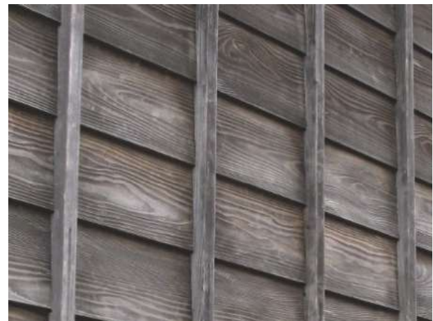
さらこ状の押し縁による下見板の固定
