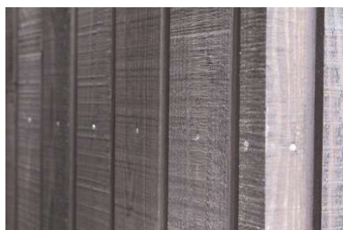
ラフゾーンに黒灰色系の塗装仕上げとした例
