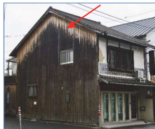
雨がかり部と非雨がかり部で 経年により様相が変わった例
