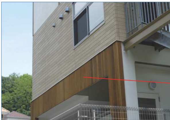
写真 1.16 RC 造建築物の外装に使われたベイスギ羽目板の退色（左：竣工直後、右：1 年経過後）
