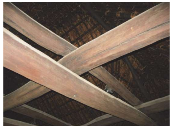
写真 1.26 150年経過後の木の色彩 (下に囲炉裏あり)
