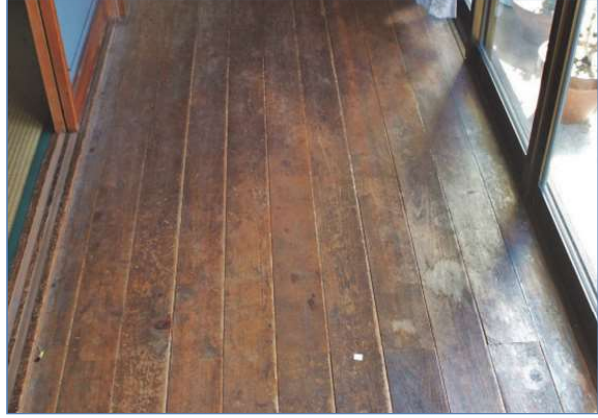
写真 1.6 ヒノキ縁甲板の幅反り（窓際で顕著）
