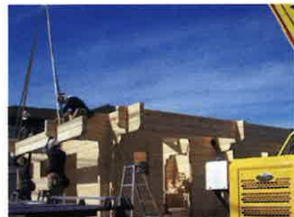
社員大工を抱え、自社施工にこだわる。全国に出張もする。日本独特の雨・湿気対策に関する施工ノウハウも備える
