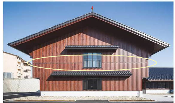
木板外壁の水切り
