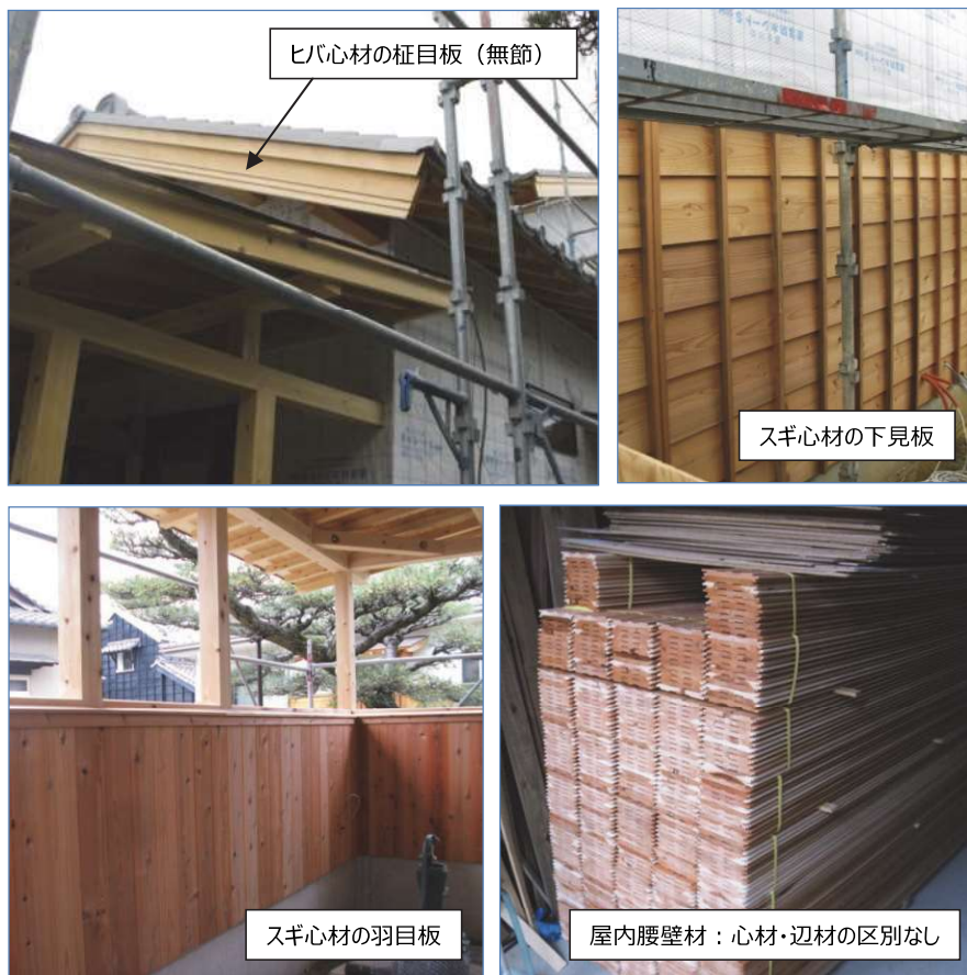
写真 3.3 伝統的工法で建築中の民家の例
