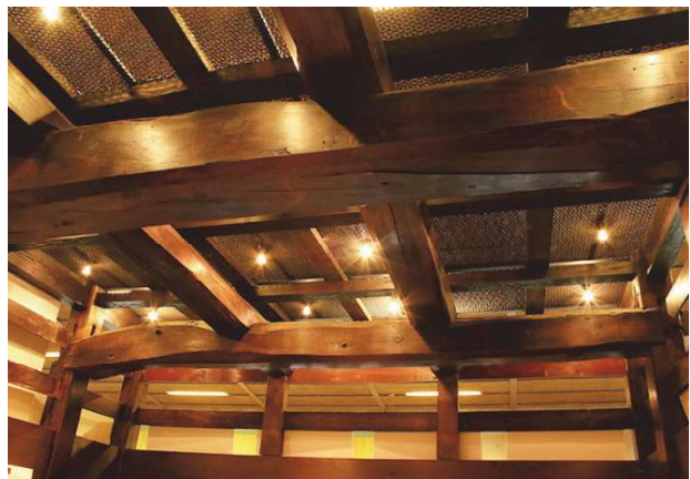
写真 1.4 架構美の一例（民家）
