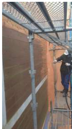
既存塗膜の除去
