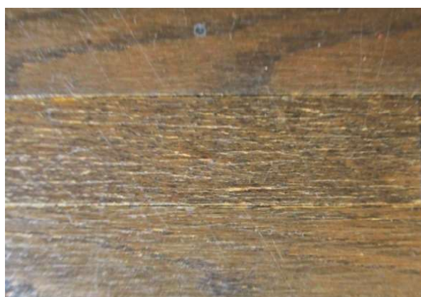
写真 1.9 掃出し窓付近の複合床板の変状（表層の化粧突板の干割れと部分剥離：18年経過）
