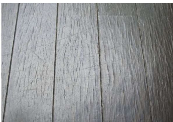
写真 1.9 掃出し窓付近の複合床板の変状（表層の化粧突板の干割れと部分剥離：18年経過）
