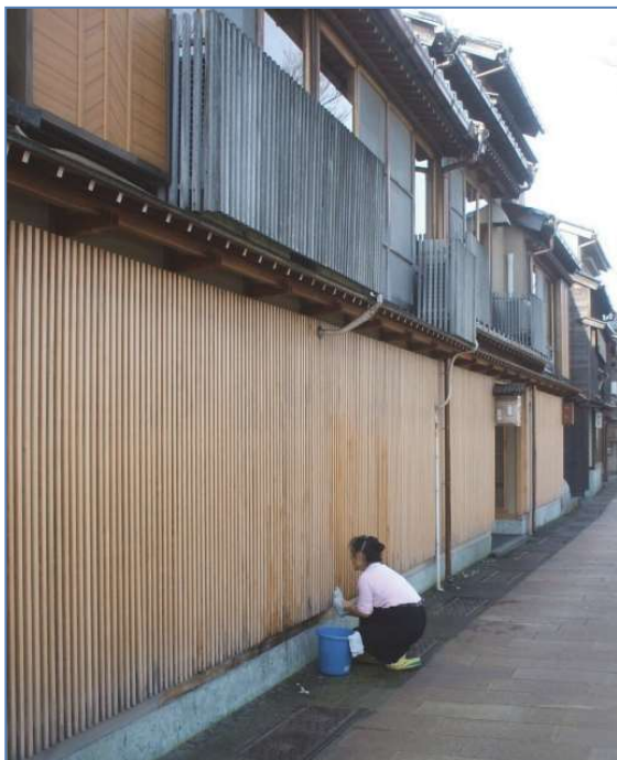
写真 4.3 無塗装材の吹き掃除の様子 (オーナー自ら雨後に拭き掃除をしている)
