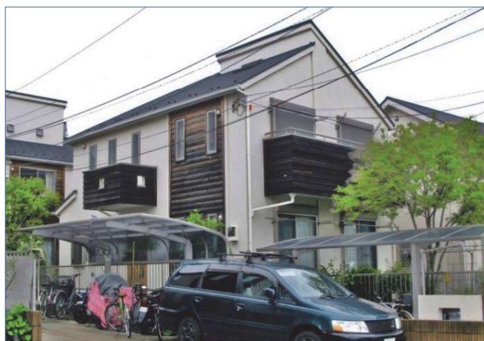
写真 1.20 黒カビの発生状況（ほぼ均一に黒色化した場合は違和感がない）
