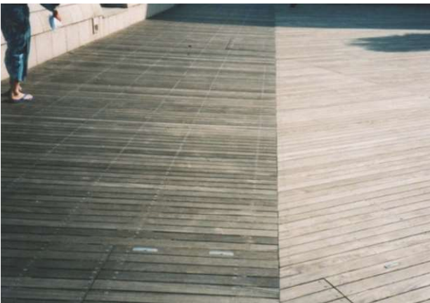
写真 1.3 配列を変えることによる光沢の違い
