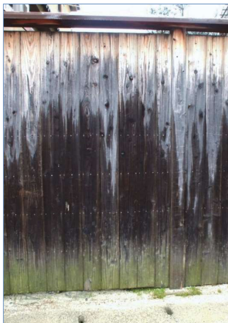
写真 1.19 スギ板塀（西面）の複合汚染（地際部では跳ね返り汚染も発生）
