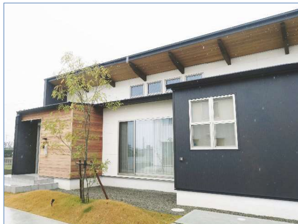
戸建住宅（たる木は斜めにカットしてある）
