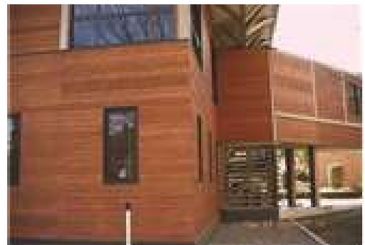
写真 3.5 半透明仕上げ（含浸形）
