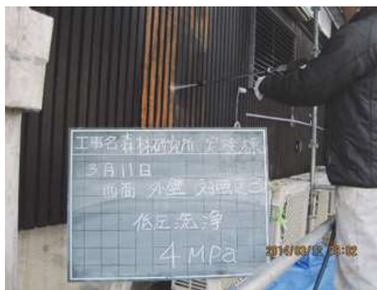
写真 3.8 高圧水洗浄法による既存塗膜の剥離工程 （この例では材面保護のため比較的低圧に設定）
