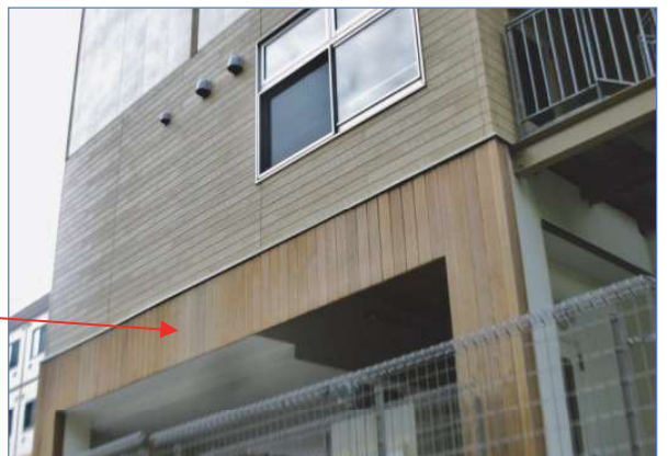
写真 1.16 RC 造建築物の外装に使われたベイスギ羽目板の退色（左：竣工直後、右：1 年経過後）
