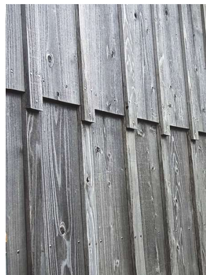
縦板張り・目板押さえの外壁
