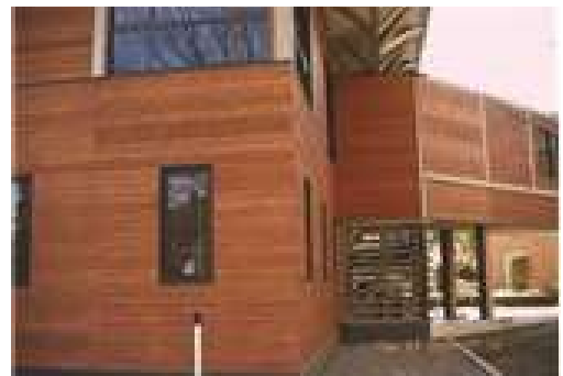
写真 3.5 半透明仕上げ（含浸形）
