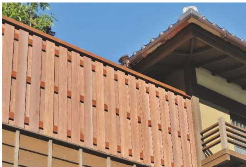
大和張りによる露天風呂の外周囲い
