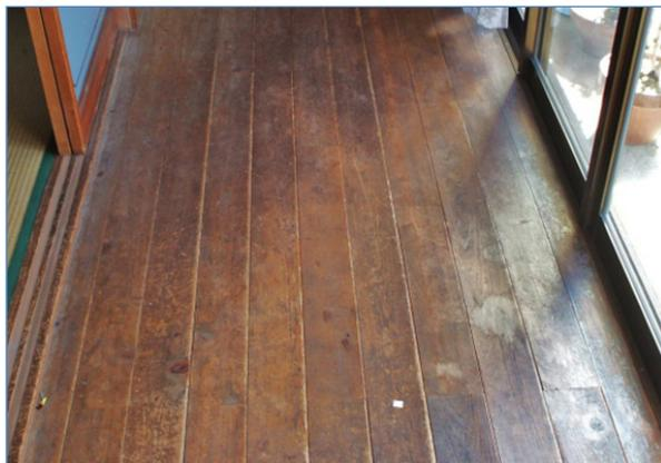
写真 1.6 ヒノキ縁甲板の幅反り（窓際で顕著）
