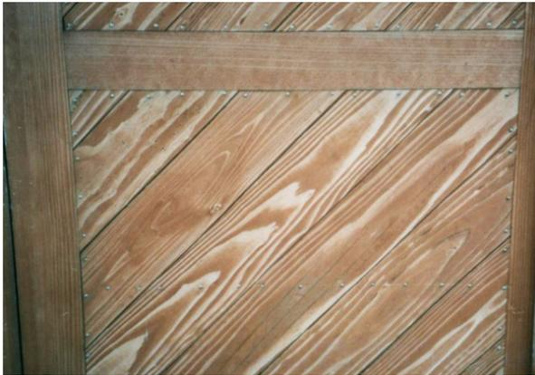
写真 1.12 含浸形塗装の色抜け
