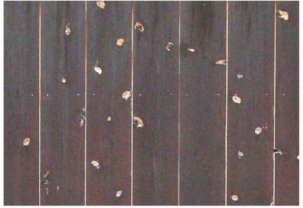
写真 1.11 造膜形塗装における節部の塗膜脱落
