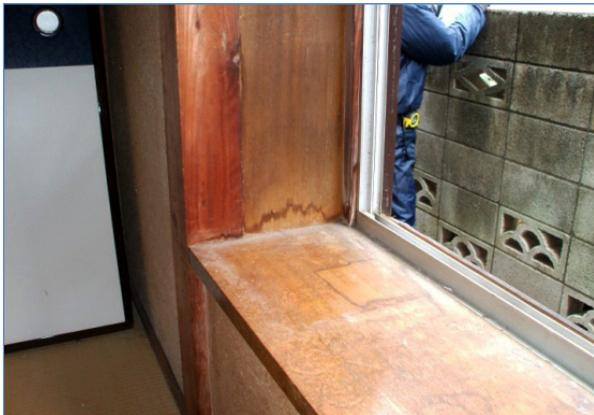
写真 1.14 窓枠に発生した雨染み（室内側）
