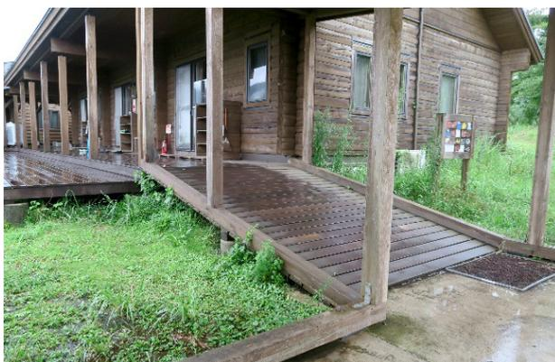
**敷板間の目地部分の隙間埋め：**商業施設などの人が多く集まる場所の木製床では、敷板と敷板の間の目地部分の隙間を埋めて物（コインなど）の落下を防いでいる。所々に換気のための穴を空けている。
