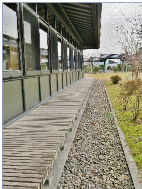
雨水の落下地点に平板を置いたため、水の跳ね返りで木材の汚れや傷みが生じている
