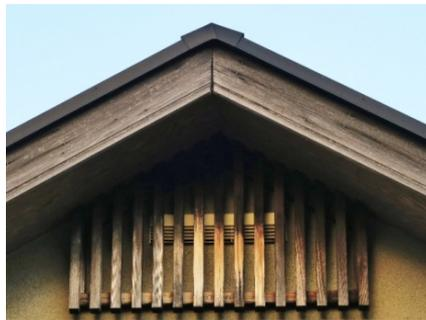
破風の栞に発生した隙間（対策しない場合）
