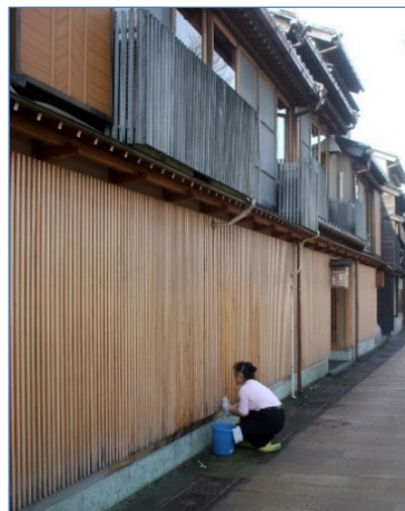
金沢市 主計町 (降雨後に住民が外壁の拭き掃除を実施)
