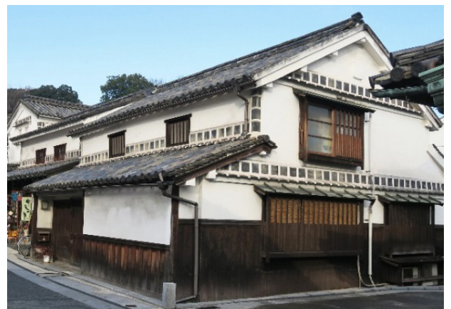
下屋と取り合う外壁面 が汚れている例
