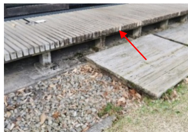
雨水の落下地点に平板を置いたため、水の跳ね返りで木材の汚れや傷みが生じている
