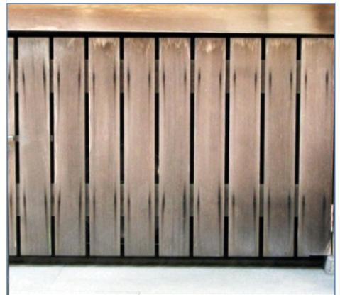
写真 1.13 板塀固定金具による鉄汚染
