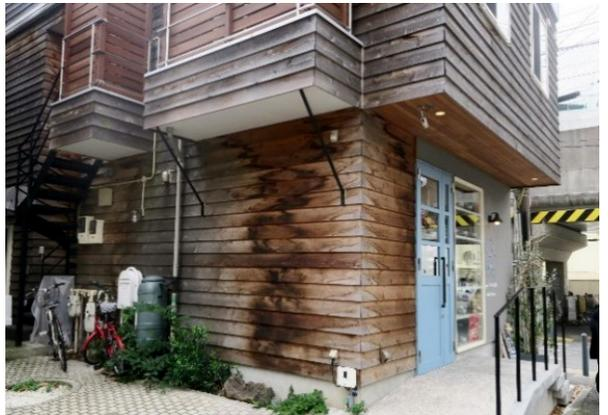
写真 1.15 南京下見板（ベイスギ無塗装）の雨染み
