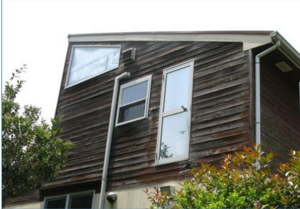
写真 1.5 下見板の幅反り及び縦反り
