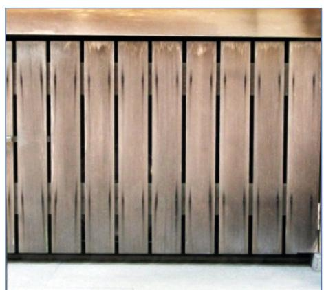
写真 1.13 板塊固定金具による鉄汚染
