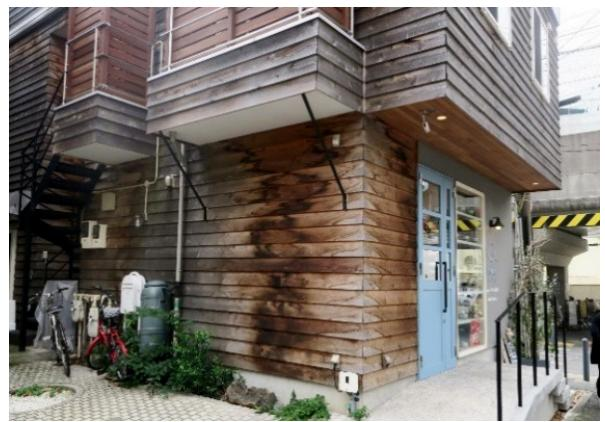
写真 1.15 南京下見板（ペイスギ無塗装）の雨染み
