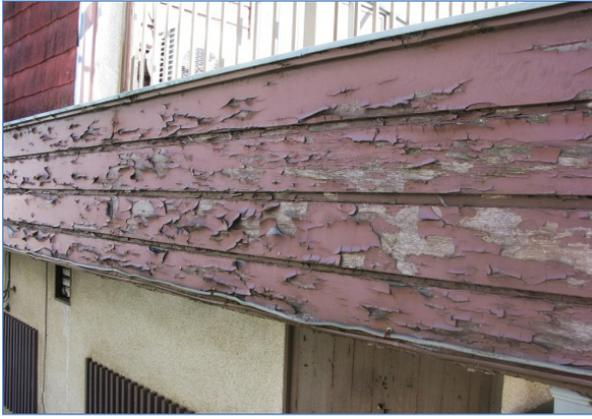
写真 1.10 造膜形塗装の塗膜剥離
