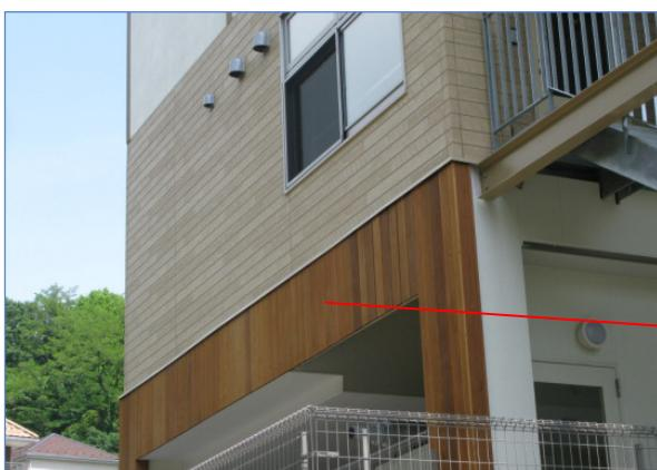
写真 1.16 RC 造建築物の外装に使われたペイスギ羽目板の退色（左：竣工直後、右：1年経過後）
